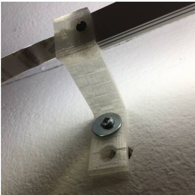
Detailaufnahme Alu-Profil mit Diffusor von oben
