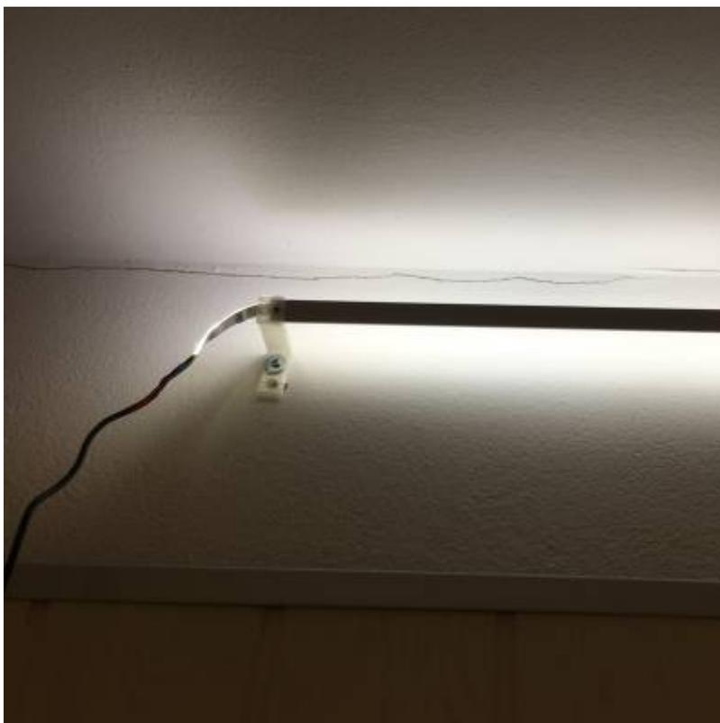
**Detailaufnahme 3D-gedruckte Halterung**
