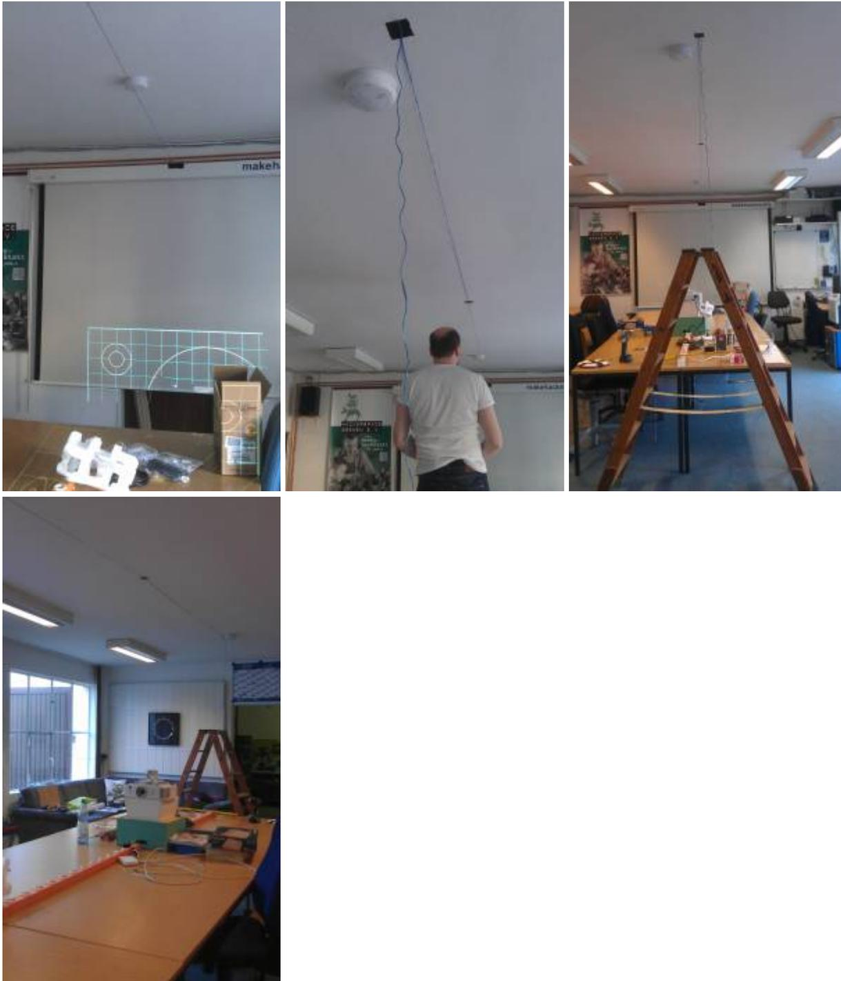
Das mit dem Panelbrett ist zwar ausreichend stabil, aber ggf. noch nicht final in der Optik. Es sind insgesamt 6 lange Schrauben verwendet worden, davon 4 in den Deckenbalken rechts und links und zwei mit diesen Hohlraumdübeln:
